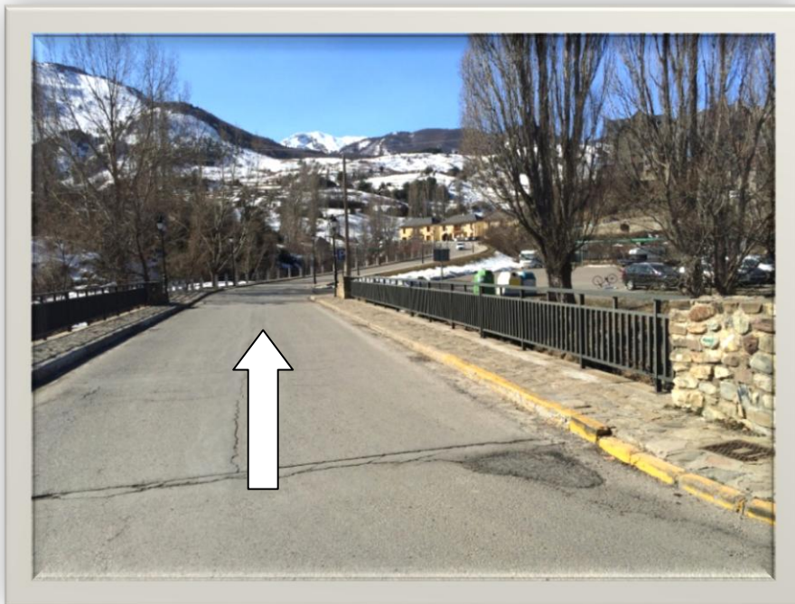
Calle Puente Romano
